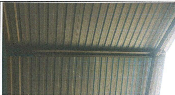
Foto 2: colocacion de laminas troquelada y capote para lamina troquelada, en el area donde era necesario.
