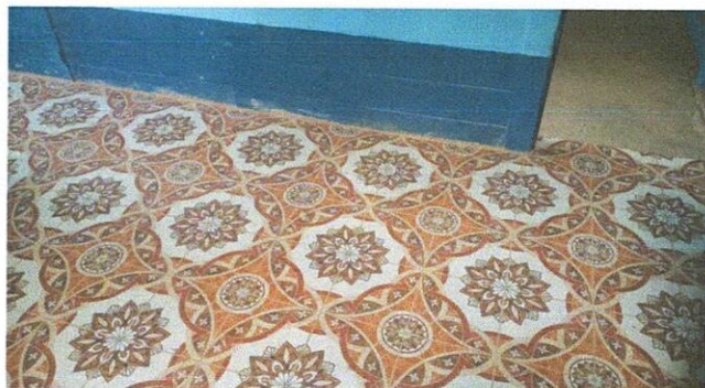
Foto 7: piso ceramico en la cocina y area de bodega de la cocina
