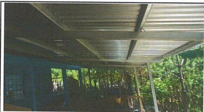
Foto 3: estructura de metal para mayor seguridad se amplia el espacio y entechado del area de la escuela con una mejor vista.
