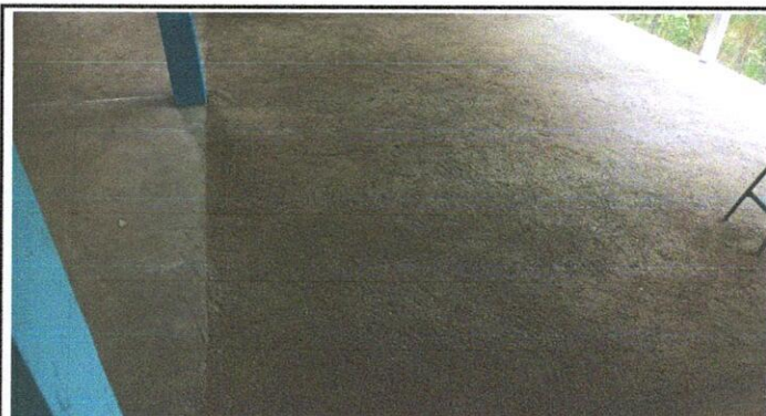
Foto 8: plancha losa concreto en el corredor y se amplia el espacio
